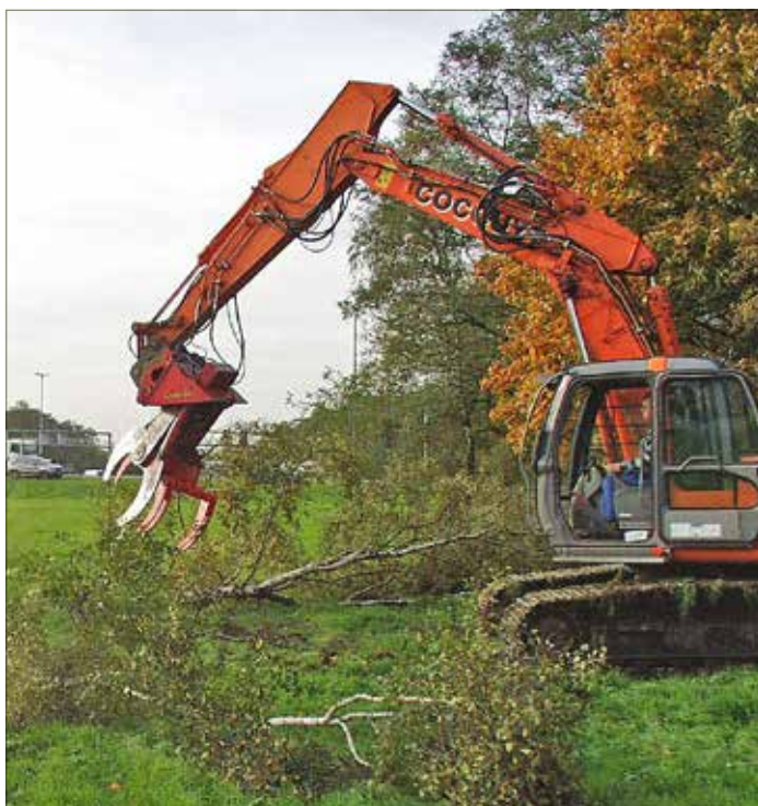
Een hydraulisch bediende tang aan het werk
